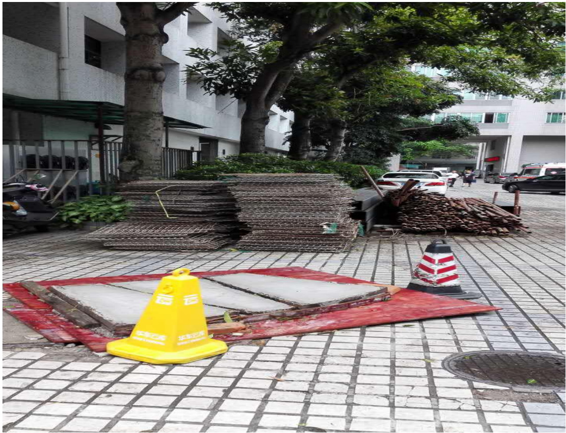
建筑材料随意堆放。
